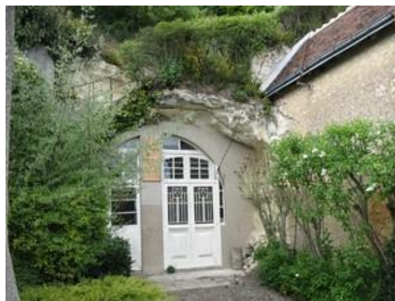
Ancienne chapelle et habitation troglodytiques
