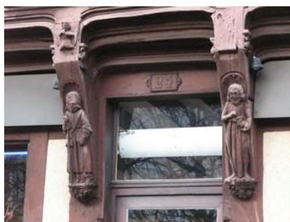
Détail de façade
